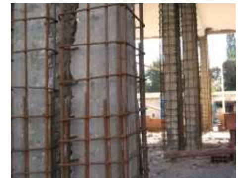
Chemisage ou gainage de poteaux (J-D)
