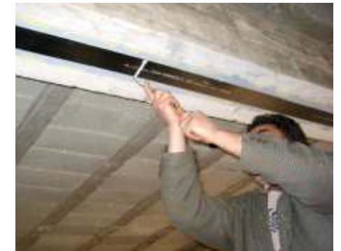
Poutre renforcée par collage de lamelles en carbone
