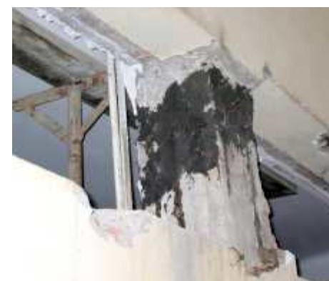
fissuration interne réparée par injection de résine
