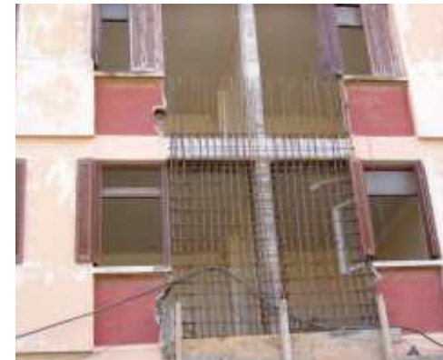
Chemisage poteaux, poutres et nouveaux voiles
