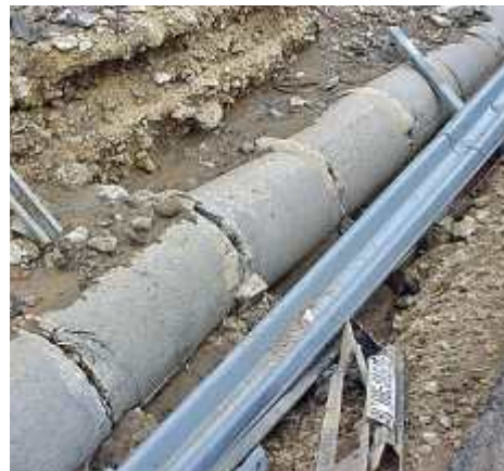
Fig. 8 - Endommagement du réseau d'assainissement dans la région sinistrée.
