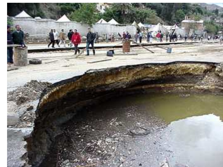
Fig. 2 - Naissance d'un cratère de 10 mètres de diamètre environ.
