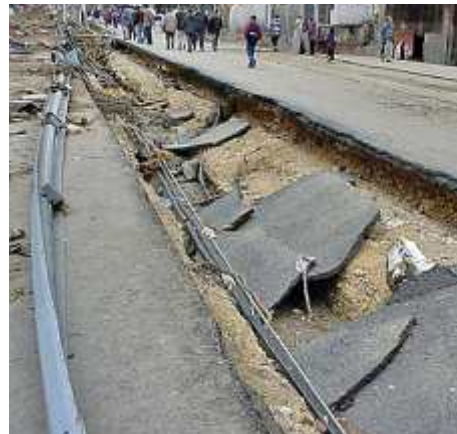
Fig. 9 - Détérioration des couches de base et de roulement de la chaussée.
