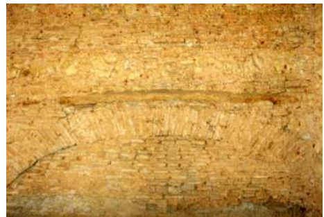
Fig 1b - Murs renforcés par une strate de brique curviligne (palais du Dey)
