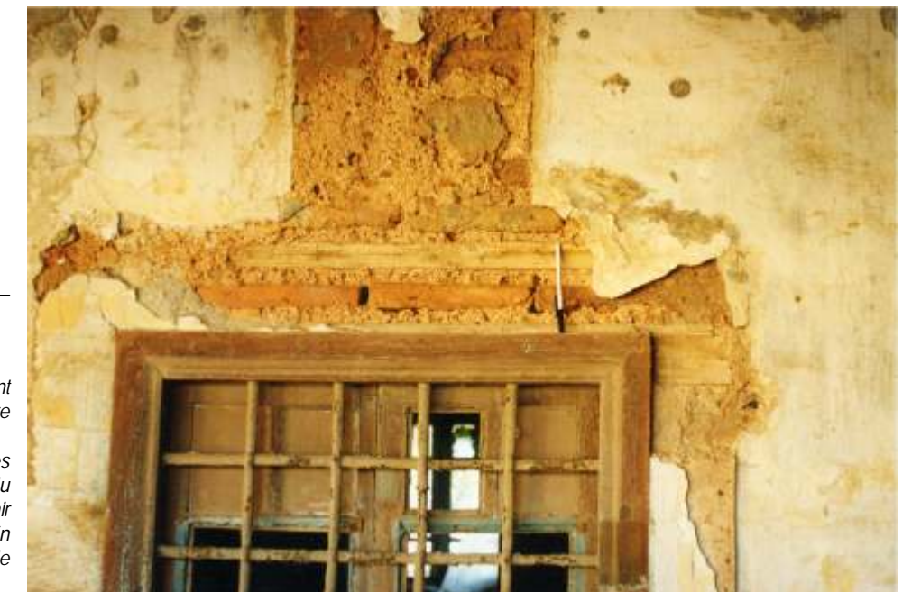
Fig 9- Renforcement des ouvertures avec du bois (Palais du Dey et maison du fahs)
