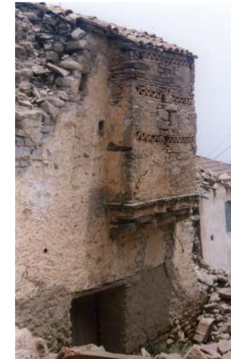
Fig 8c - Encorbellements non détruits à Dellys
