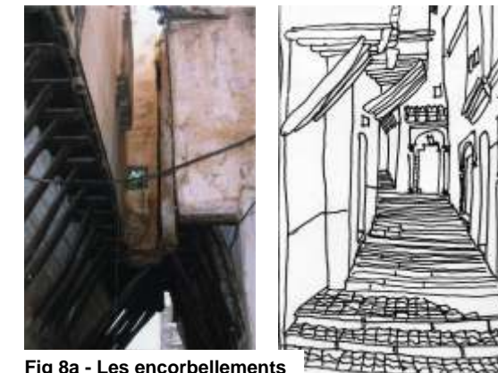
Fig 8a - Les encorbellements
