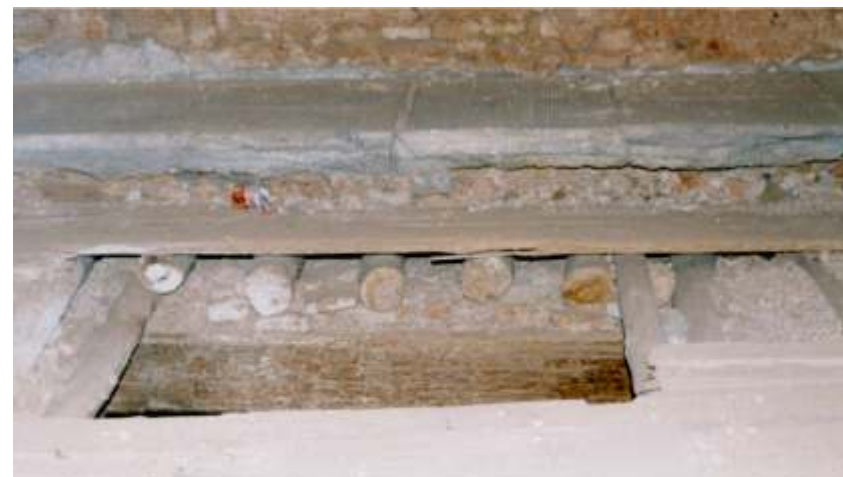
Fig 7b - les planchers sont constitués d'une superposition de rondins de thuya insérés dans toute l'épaisseur du mur, créant une différence de niveau. Entre deux rangées de bois est disposé un voligeage qui permet le mouvement par roulement ou glissement
