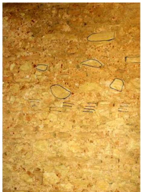
Fig 1c - Mur en briques renforcé par des blocs de pierres (opus mixtum) (palais du dey)
