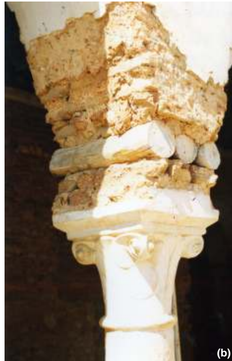
Fig 6 - (a) - Détail départ arc : superposition de deux rangées de thuya (b)- Détail départ arc : une rangée de thuya
