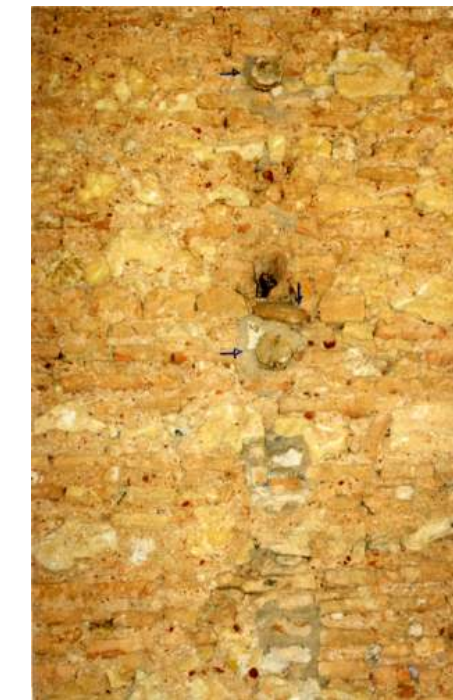
Fig 4 - Chaînage des cloisons aux murs porteurs (palais du dey)
