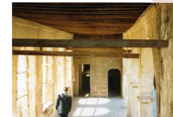
Fig 5c - Contreventement par les poutres en bois ( palais du dey).
