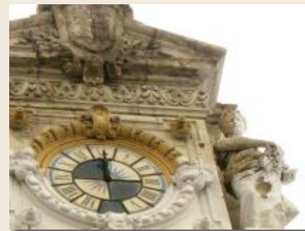
Avant le séisme le 15/03/2003
