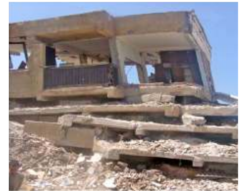
Fig III-6 Mode de collapse en éventail. (Mouvement de rotation)
