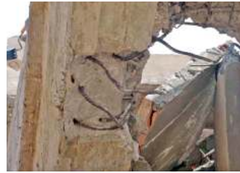
Fig III-4 Déboîtement du poteau par rapport à la poutre. (Présence d'une surface lisse)
