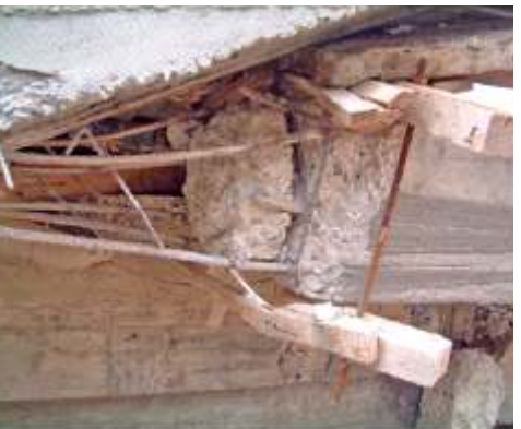
Fig III-1 Éclatement d'un dés, dont témoigne le coffrage encore présent. Boudouaou
