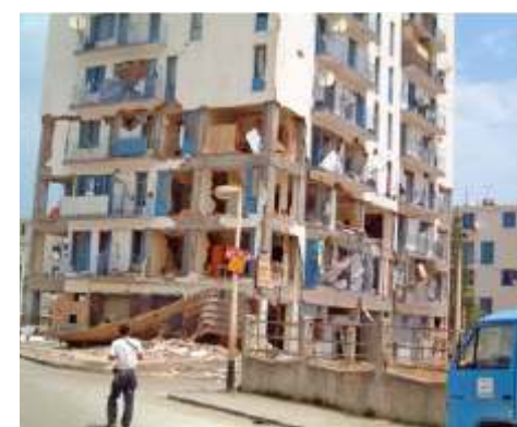
Fig III-10 Immeuble "15" effondré par effet de torsion suite à la réplique du 27/05/03.
