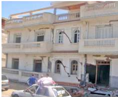
Fig 1-3 Zemmouri, rez-de-chaussée atteint, les autres étages épargnés en raison de la différence dans la qualité du béton
