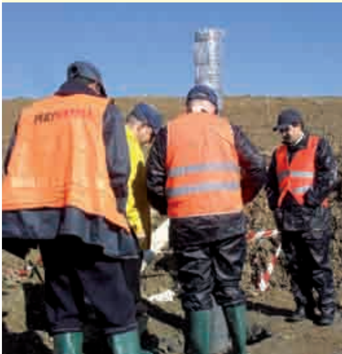
Visite sur le site de la réhabilitation de la décharge de Oued Smar à Alger - Février 2011
